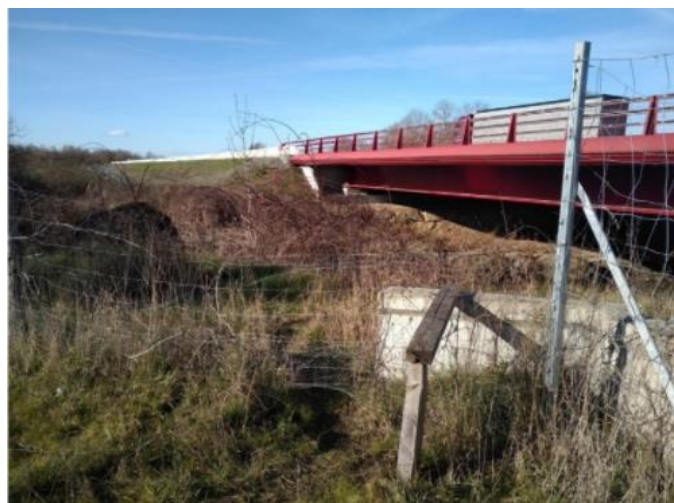
Figure 10 : Coulée passant sous le grillage de part et d'autre de l'ouvrage
